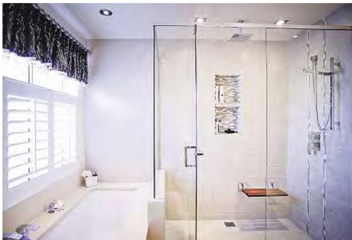
La douche sans seuil, avec banc escamotable, est séparée du bain par un muret de céramique surmonté d'une vitre. Le bain est profond, dans un podium de merisier (non visible sur cette photo), couronné d'une tablette de quartz.
